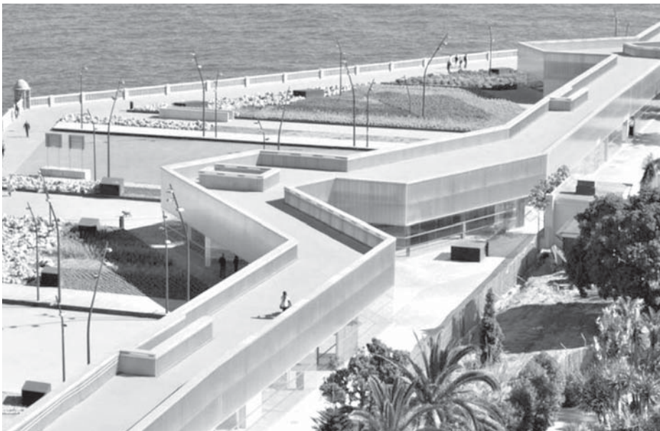
Recreación de la Pérgola de Santa Bárbara al término de los trabajos de rehabilitación previstos con un presupuesto de 990.641,86 euros. VIVA
