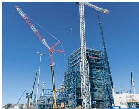
Montaje de la caldera de recuperación de calor de CirCular. VH
