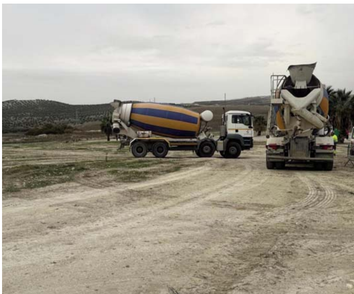
Obras en los terrenos del Cetedex. ESPERANZA CALZADO
