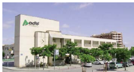
Estación de tren de Jaén. ADIF
