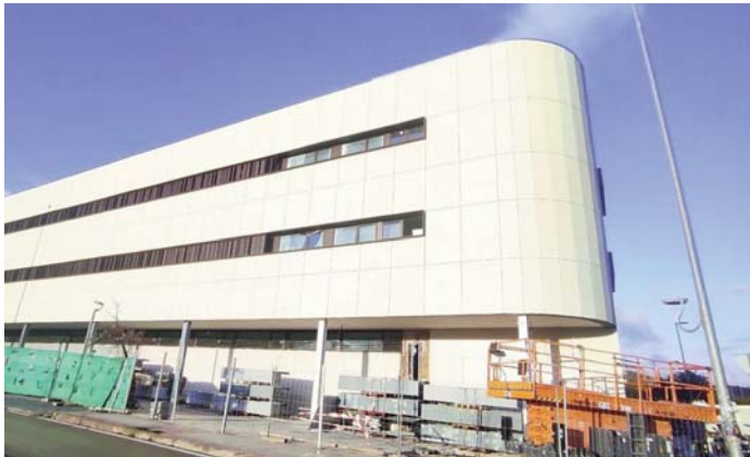
Sede en construcción del Conservatorio Superior de Música EUROPA PRESS
