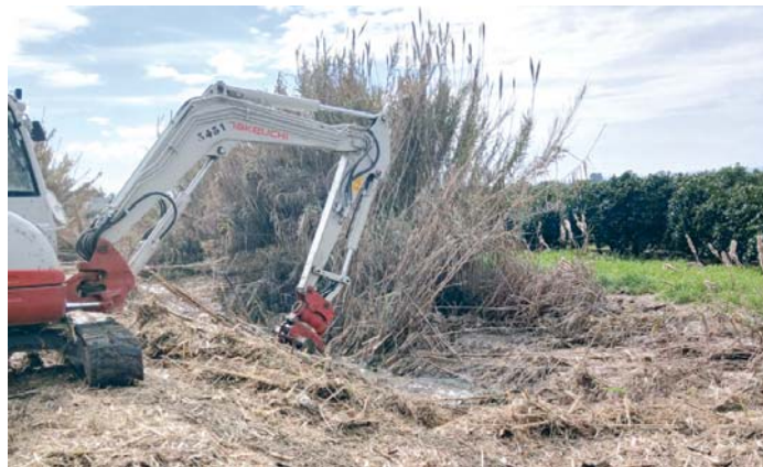
Tareas de mantenimiento de los cauces no urbanos realizada por la Confederación del Guadalquivir. CHG
